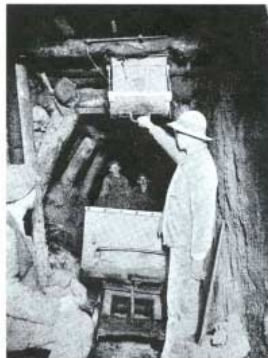
Abb. 22: Stollenausbau. Schieberverschluss des Füllrohrs. Ein Arbeiter in Arbeitskleidung (Foto aus Beitr. Geologie der Schweiz, geotechn. Serie, Lief. 12, 1925)
